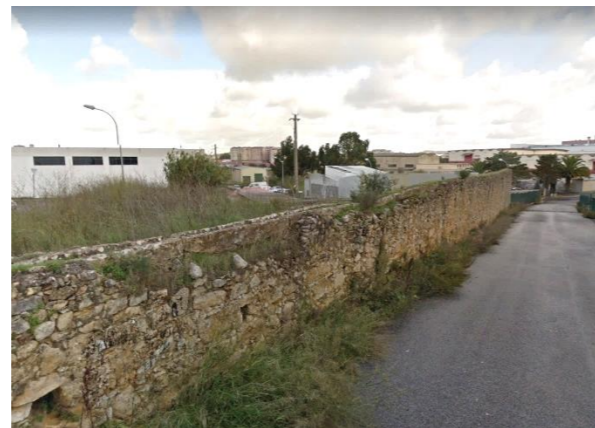
Troço do aqueduto de Vale Mourão, Zona Industrial da Bela Vista
